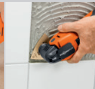
Tvrdokovová rašpľa odstraňuje lepidlo na dlaždice a zaisťuje vyrovnaný podklad.
