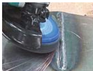
*odstraňovanie farebných defektov po zvaroch
