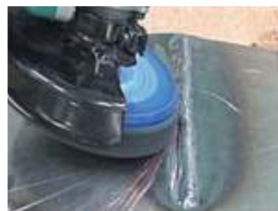
*odstraňovanie farebných defektov po zvaroch
